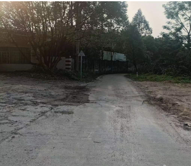
村道 C102 现状照片
